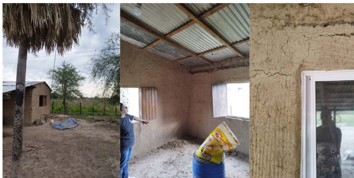
Figura 3. Vivienda realizada en adobe, 2021. Fuente: fotografías propias, 2025.
