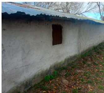
Figura 5. Vivienda tradicional de barro y tacuara en estado de uso en Lomas de Vallejos. Fuente: fotografía propia.
