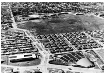
Figura 7. Expansión urbana hacia el sur de Corrientes. Barrios 300 Viviendas y Tejas.
