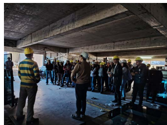
Figura 2. Imágenes 4,5 y 6. Visita de obra a la Unidad, y Torre en costanera. E3 estudio Fuente. Elaboración propia.
