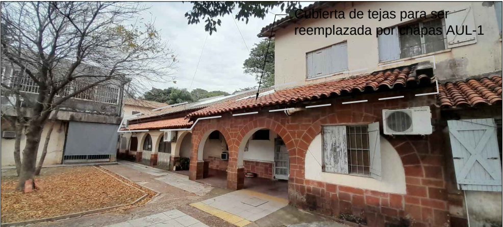
FOTOGRAFIA 1 _ Area de cubierta a intervenir. Faldon Decanato Facultad de Arquitectura y Urbanismo.
