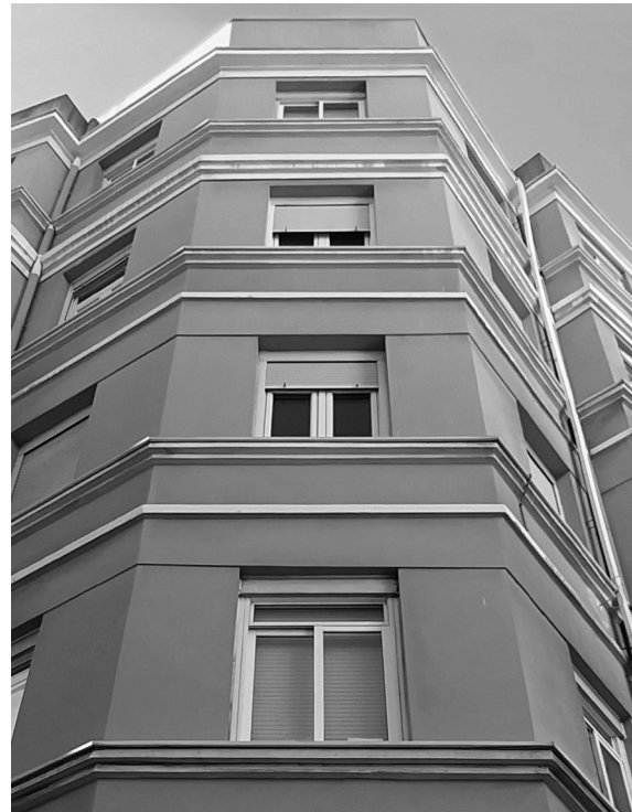
Figura 4 Rúa Falperra, 78. A Coruña (2025)
