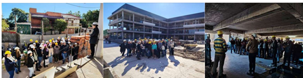
Figuras 4, 5 y 6 – Visita de obra a la Unidad, y Torre en costanera - E3 estudio – Ciudad de Corrientes 2025. Fuente: elaboración propia
