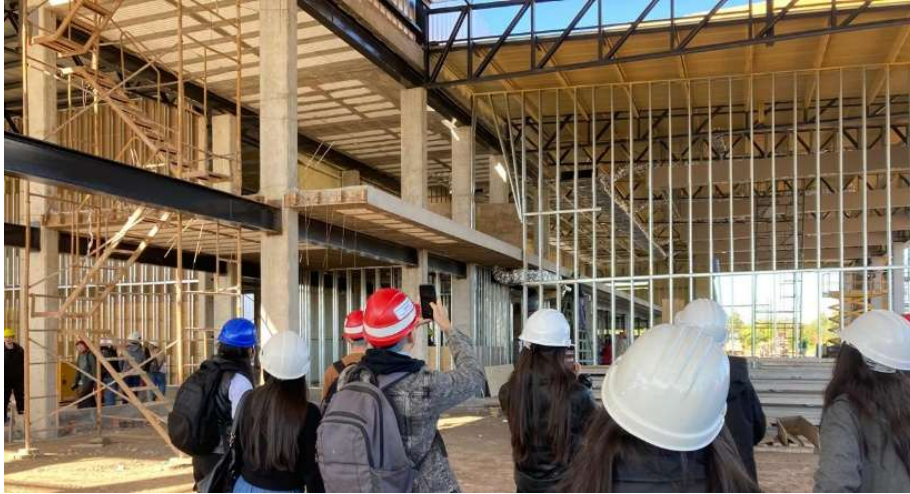
Figura 3: Visita de obra realizada en el ciclo lectivo 2025. Fuente: elaboración propia.
