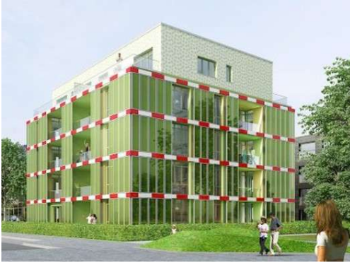
Fig. 3 - Edificio BIQ, Hamburgo (Alemania).
