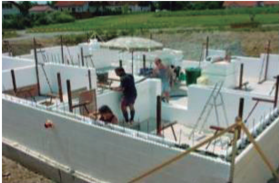
Figura N°2: Sistema constructivo no convencional SIMACOM. Fuente: catalogo del producto.
