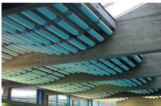
Figura N° 1: falso techo acústico con cámara de aire en su interior y placa fonoabsorbente para la absorción acústica. Fuente: catalogo del producto.
