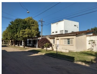
Fig. 6. Algunas de las viviendas definen modificaciones al modelo inicialmente construido
