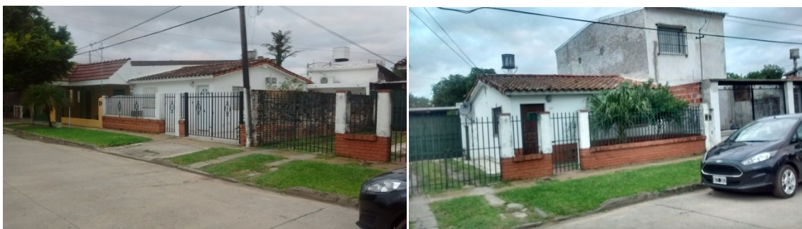
Fig. 3 y Fig. 4. Viviendas del barrio con la imagen original en la volumetría, caracterizada por la utilización de losa de hormigón armado en pendiente con tejas coloniales. Fuente: colección del autor.
