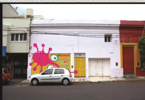
Montaje de vinilo para vidriera
